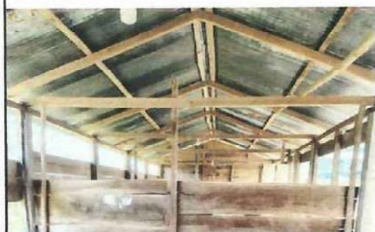
FOTO 3: SUSTITUCION DE TODAS LAS LAMINAS ONDULADAS
