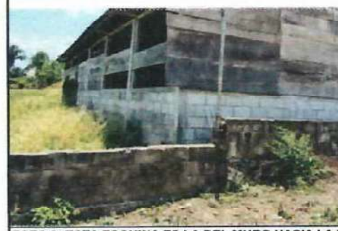
FOTO 6: ESTA ESQUINA ES LA DEL MURO HACIA LA ESQUINA DE ATRAS SE CAMBIARA COMPLETAMENTE
