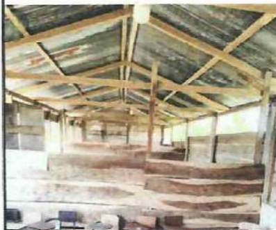
FOTO 2: SUSTITUCION DE ESTRUCTURA DE MADERA POR METAL
